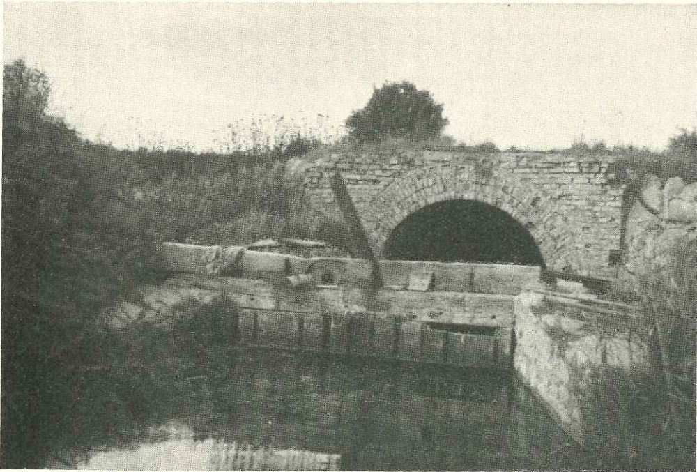
Fig. 3. Ketting Nor. Slusen set indefra. Tre Stigbord er anbragt i Udløbet fra Noret lidt inden for Dæmningen.
