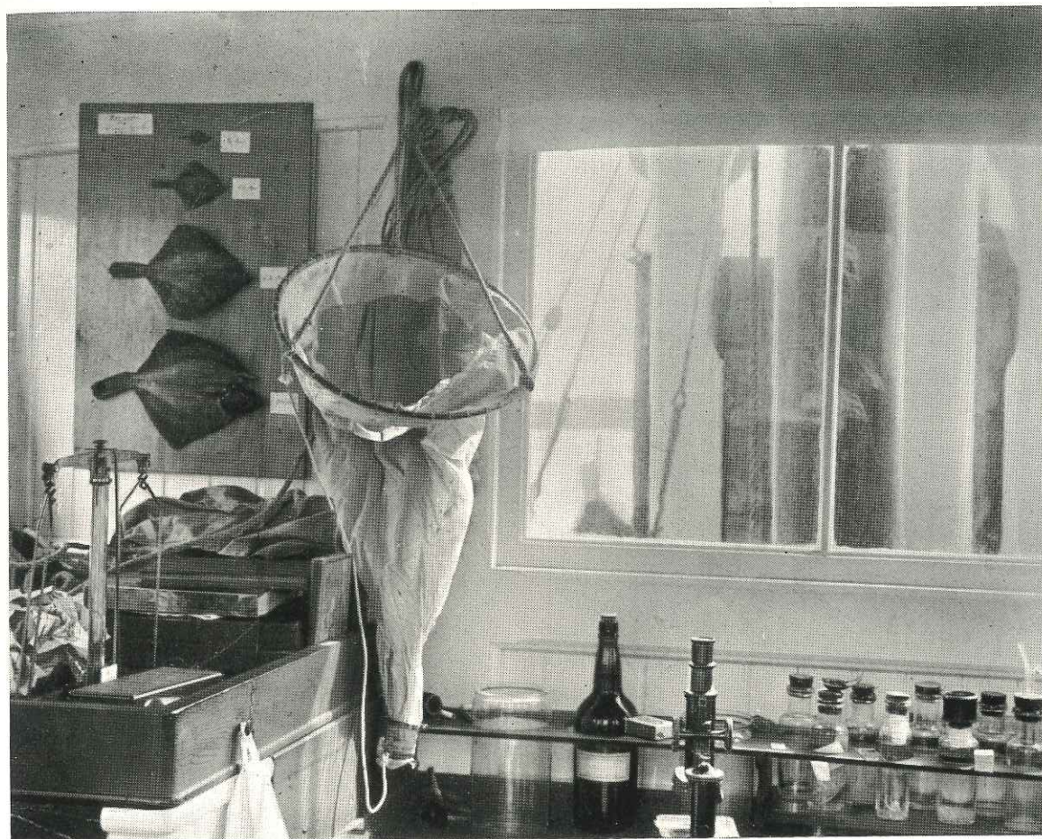
Fig. 41. Laboratoriet i »Japetus Steenstrup«. Foroven til venstre en Tavle, der illustrerer Rødspættens Vækst. Nedenfor staar en Vægt til Vejning af Bunddyr. Til venstre for Vinduet hænger en Planktonpose. H. Blegvad fot.
