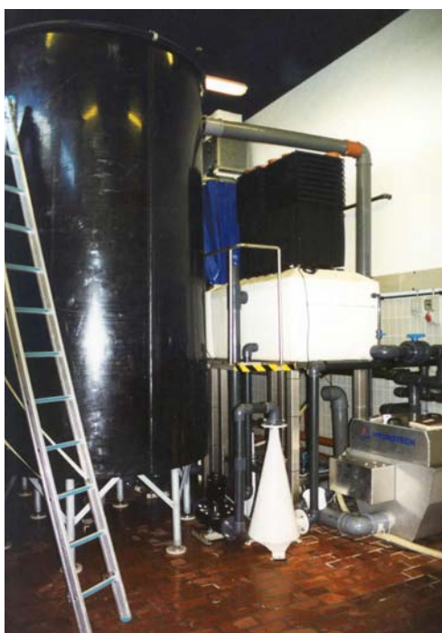
Figur 2.2. Billede af rensekomponenter i recirkuleret anlæg; den høje beholder er biofiltret som er pakket med bioblokke® (t.h). (Se Anneks 2 for detaljer)
