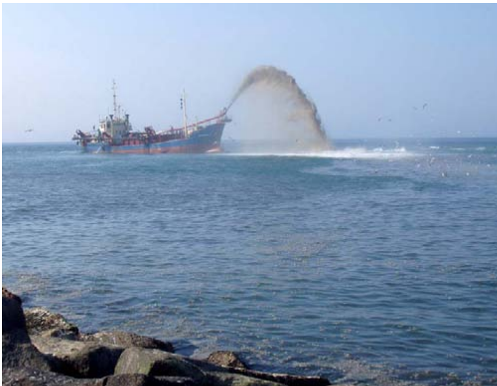
Figur 5.5. En kystfodring på lokalitet F ved Agger Tange i 2003. Bemærk de mange måger der tiltrækkes af sandfodringen til højre i billedet. Foto fra kystdirektoratet.
