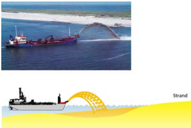
Figur 2.8. Princip strandnær fodring.
