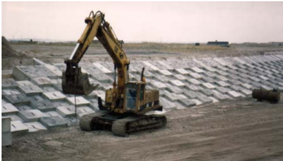
Figur 2.3. Skråningsbeskyttelse med betonblokke.
