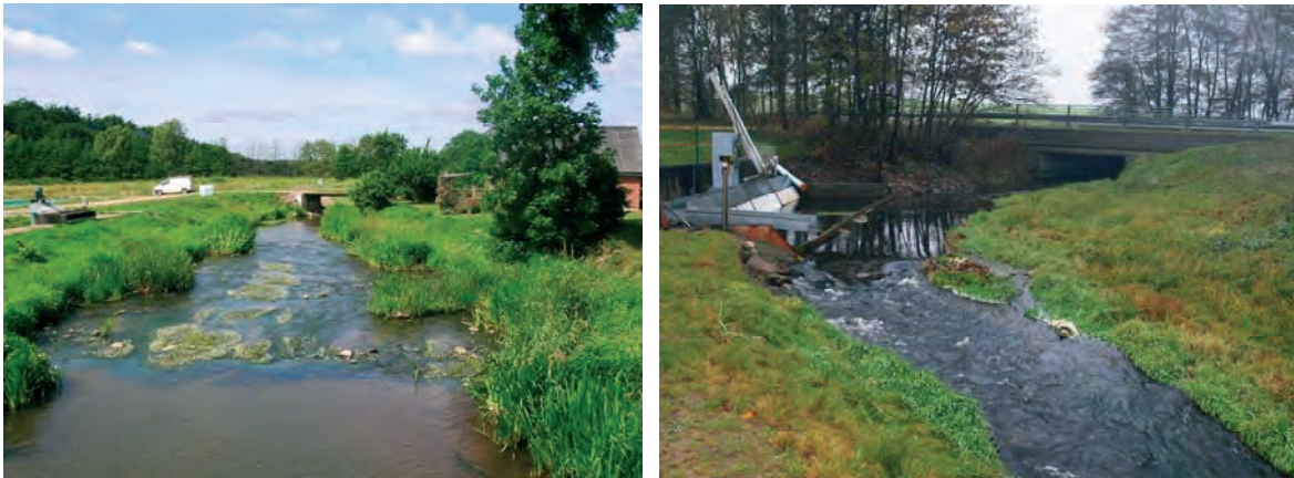
Figur 8. Omløbsstryg ved Løjstrup Dambrug (venstre billede), og ved Bregnholm Mølle Dambrug med indløbs-riste (højre billede). Foto: Lisbeth J. Plesner.
