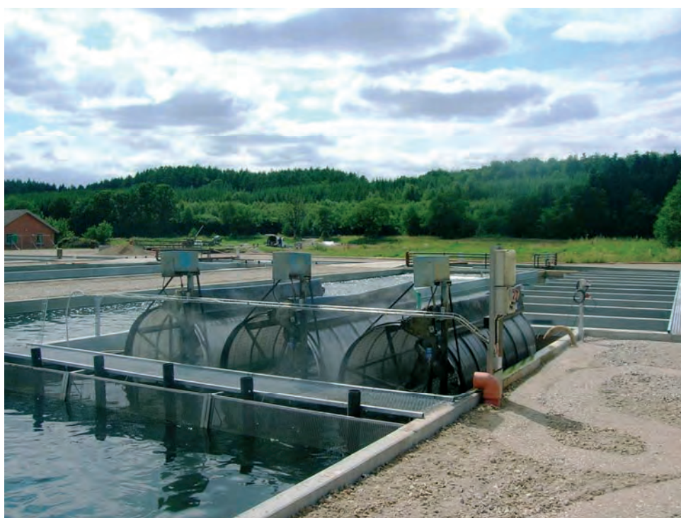
Figur 18. Mikrosigter på Løjstrup modeldambrug type 3. Mikrosigterne er placeret lige før biofilterenhederne. Foto: Lisbeth J. Plesner.
