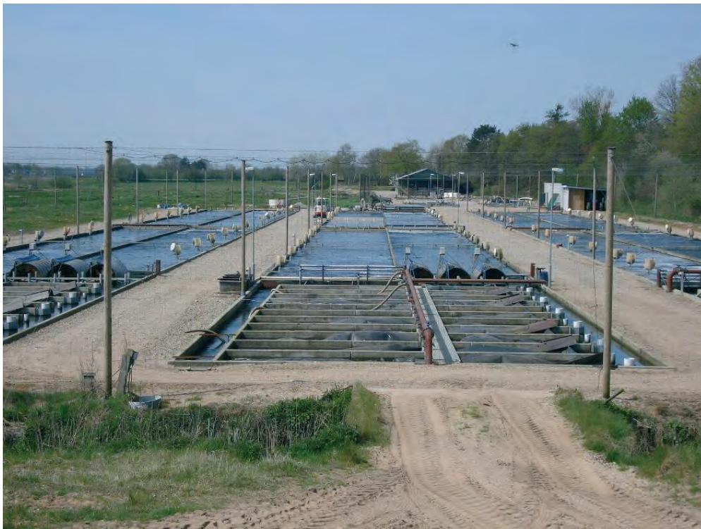
Figur 14. Kongeåens modeldambrug type 3. Produktionsenhederne omfatter 3 sektioner, der hver består af 2 beton raceways med mikrosigter (maskestørrelse 74 \mu\text{m} ) foran biofilter sektionerne (forgrunden). I baggrunden til venstre ses plantelagunerne bestående af de tidligere jorddamme og indløbs- og udløbskanaler (Svendsen et al., 2008). Foto: Lars M. Svendsen.
