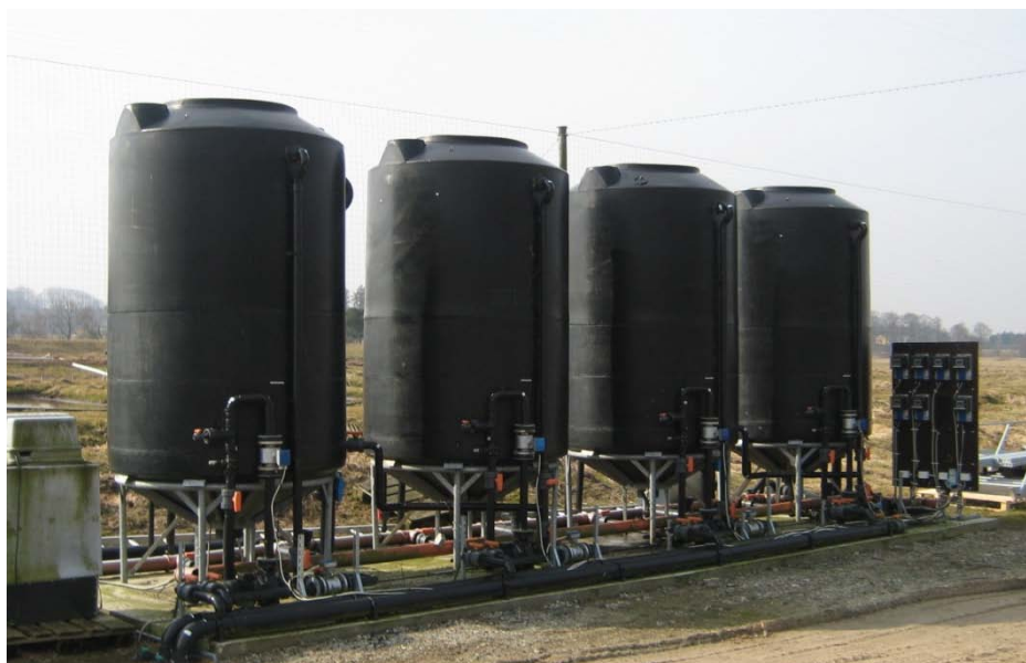
Figur 4.1. Pilotfiltrene på Kongeåens dambrug.
