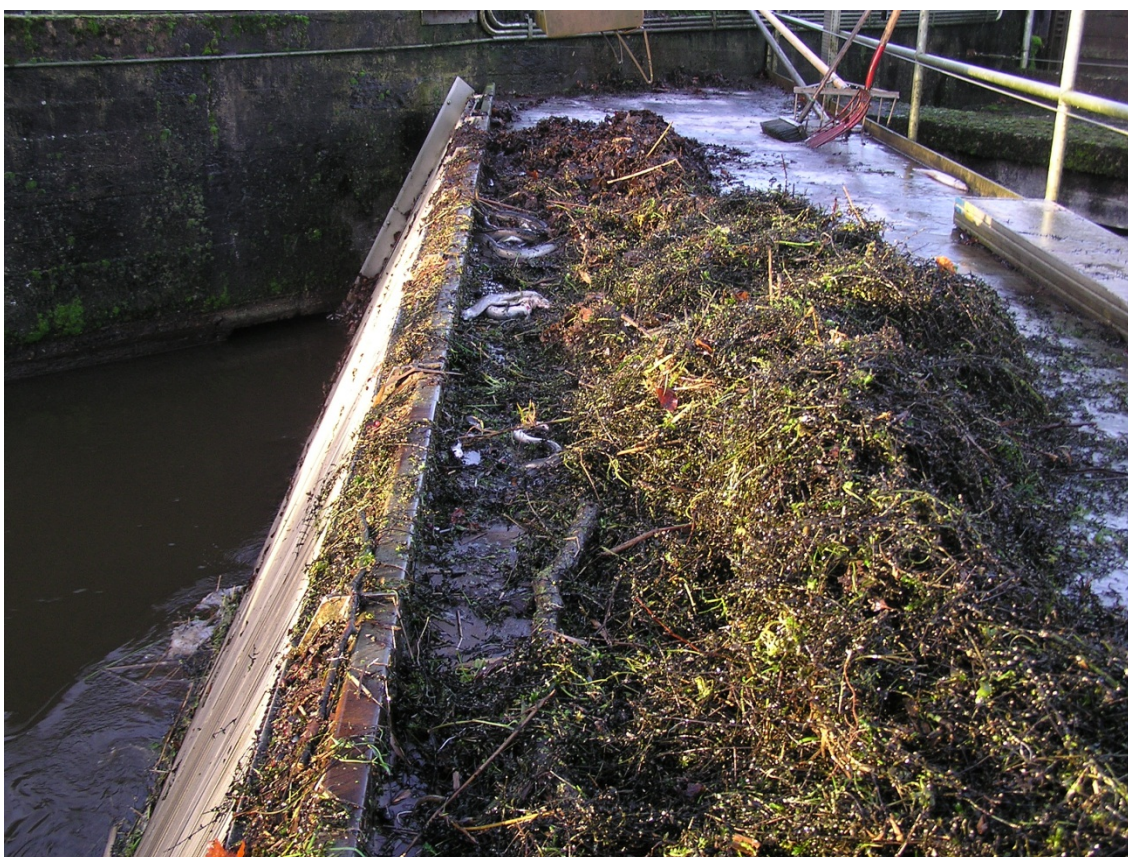
Figur 12.2. Vestbirk vandkraftanlæg. Ål fanget på gitteret og trukket op fra dette med den automatiske oprensere 15. december 2006. Foto: Michael Ingemann Pedersen.
