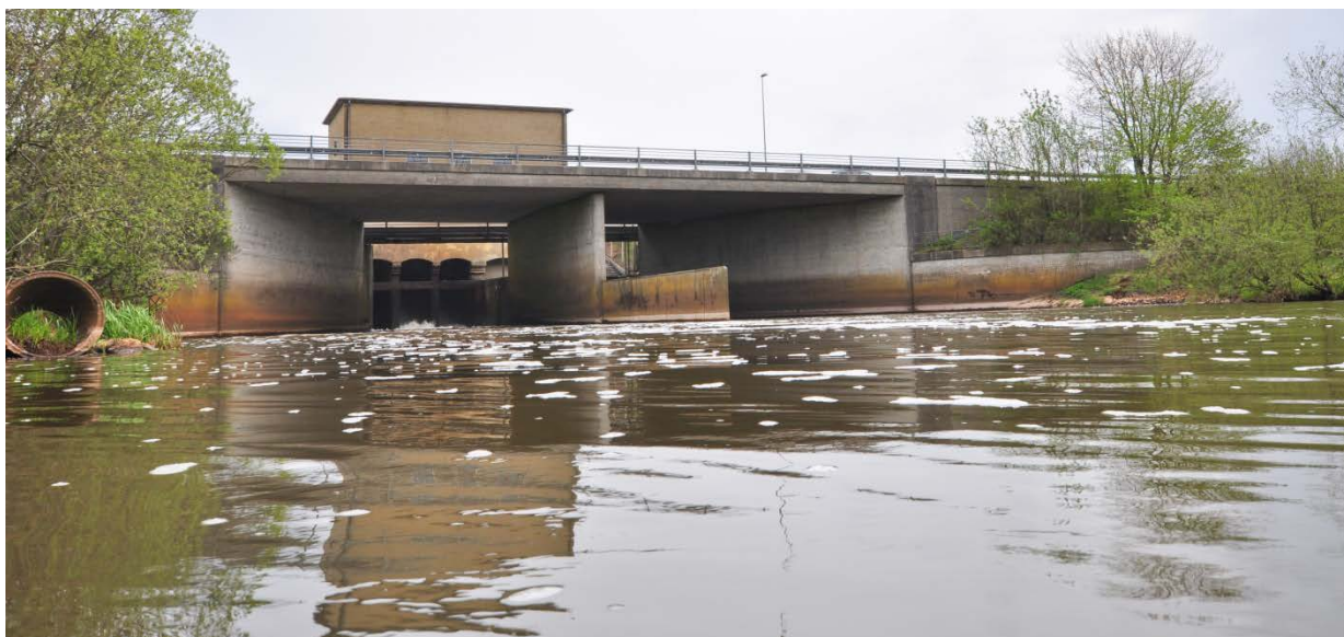
Vandkraftværket hindrer at fisk har fri adgang til de gyde- og opvækstområder, som eksisterer i Storå-systemet. Produktionen af strøm stoppede i 2011.
