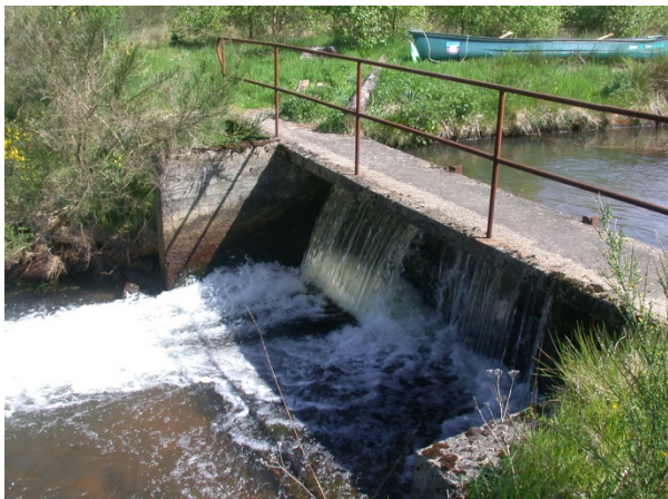
Rind Å forvirringen hindrer fri adgang til gydeområde i en stor del af Skjern Å-systemet og opgangsfisk springer ind i betonbygværket.
