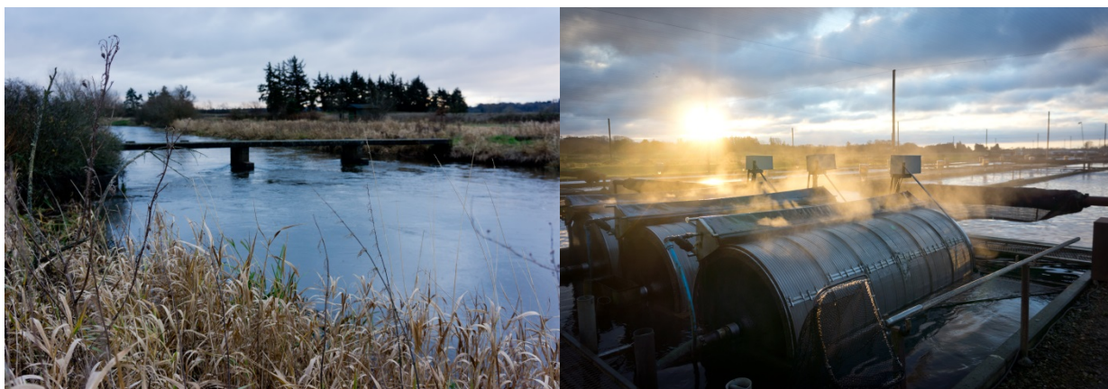
Opstemningen ved Kongeåens dambrug er fjernet, og i dag er der kun betonbygværket tilbage. Kongeåens dambrug ligger stadig ved Kongeå og har udvidet produktionen i forbindelse med, at det er overgået til model 3-dambrug. Denne type dambrug anvender markant mindre vand og bruger borings- og drænvand, men ikke vand fra åen.
