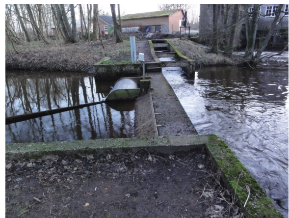
Opstemningen ved Utoft Dambrug og Ansager Mølle Dambrug spærrer for fiskenes frie adgang til egnede gyde- og opvækstområder i hhv. Grindsted Å og Ansager Å.
