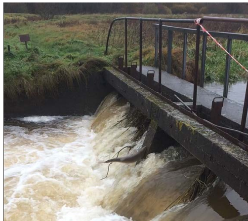
Rind Å forvirringen hindrer fri adgang til gydeområde i en stor del af Skjern Å-systemet og opgangsfisk springer ind i betonbygværket.
