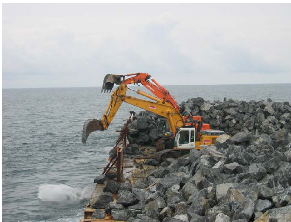
Figur 6.1. Losning af pram med brudsten fra Norge på Læsø Trindel.
