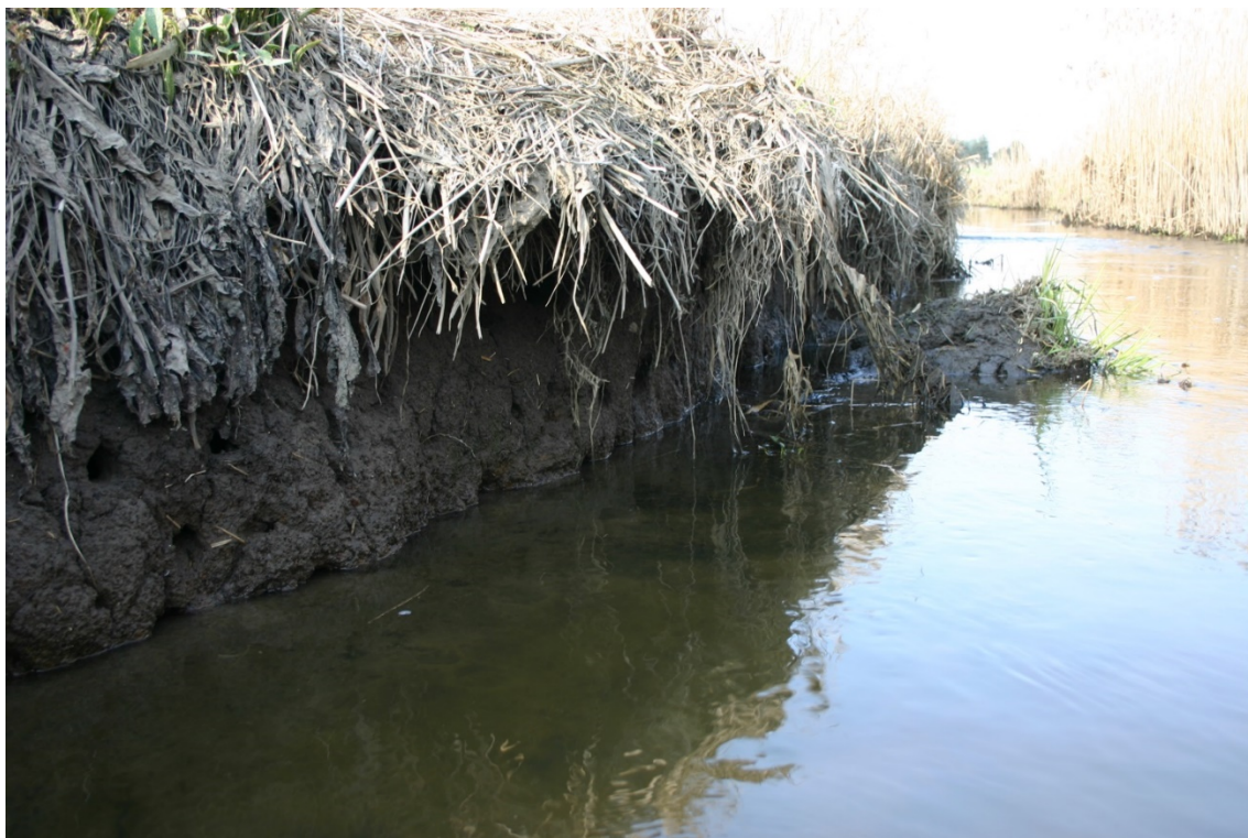
Figur 2. Brink i Alling Å april 2019 med mange huler gravet af signalkrebs. Bemærk at der er huler både over og under vandoverfladen. Øverst til højre i billedet et stykke brink, der er skredet ud og under nedbrydning. Foto Søren Berg.
