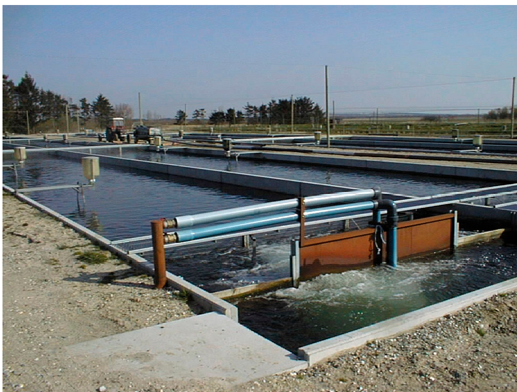
Fig. 15. Binderup Mølle Dambrug. Beluftningsafsnit efterfulgt af opdrætssektion.
