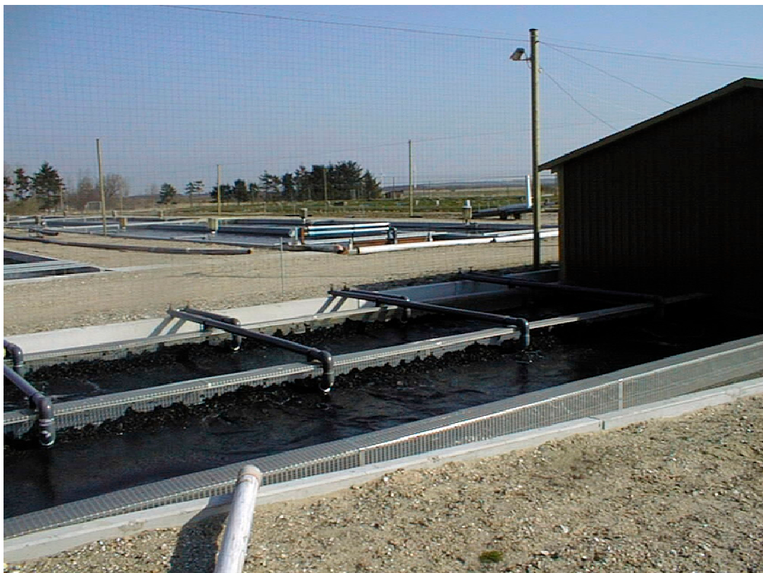
Fig. 16. Binderup Mølle Dambrug. Biofilter/moving bed. Mikrosigteanlæg findes i huset til højre.
