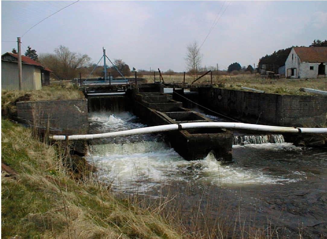
Fig. 10. Utoft dambrug. Stemmeværk, fisketrappe og frivand.
