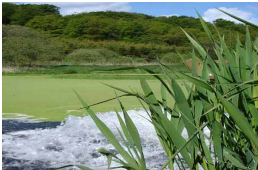
Figur 11.8 Nedstrøms del af plantelagunen ved Tingkærvad Dambrug. Forrest Høj Søgræs og i overfladen af plantelagunen en masse Andemad. Endvidere ses beluftning af vandet inden udløb til Vejle Å.
