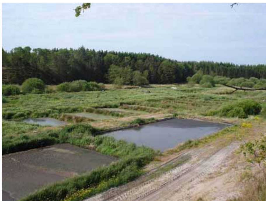
Figur 3.4 Plantelagune ved Ejstrupholm Dambrug med to slambassiner i forgrunden.
