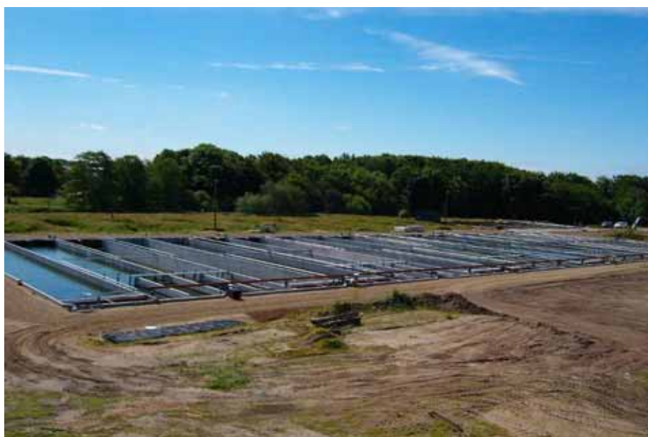
Foto16.2.3.9 Produktionsanlægget ved Rens Dambrug under opførelse.
