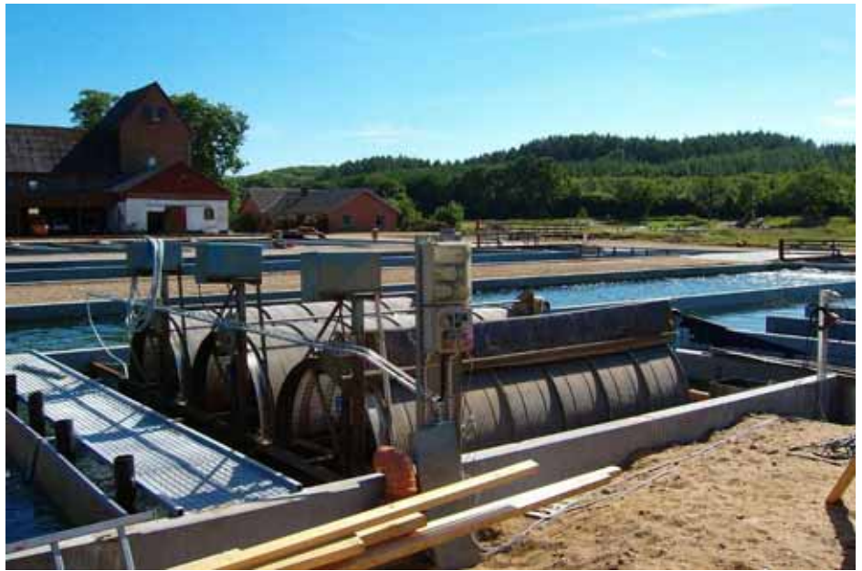
Figur 3.6 Mikrosigter ved Løjstrup Dambrug.
