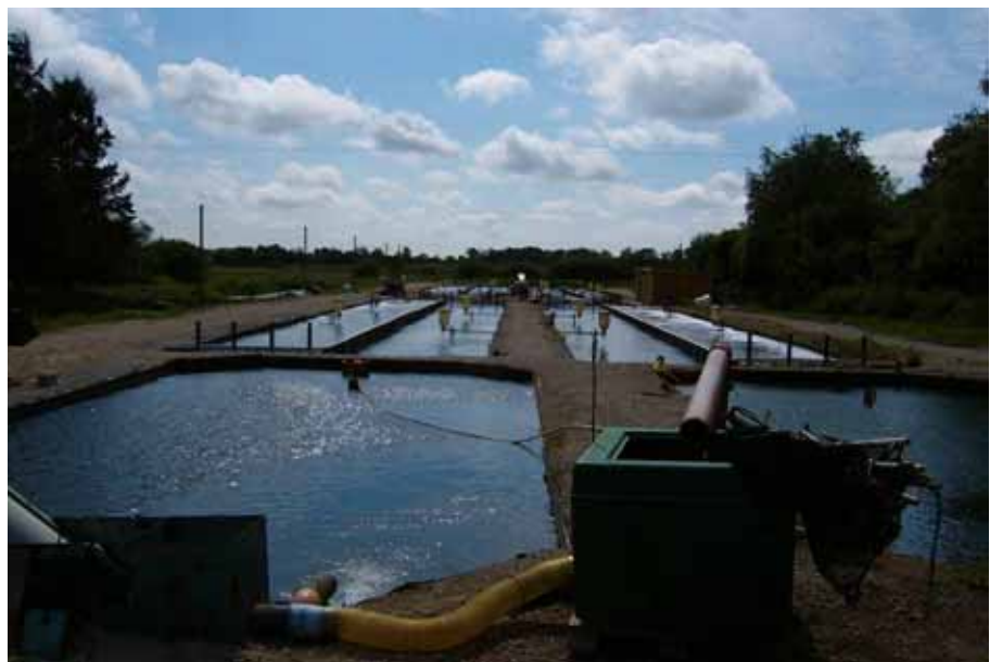
Foto 16.2.3.1 Produktionsanlægget ved Tvilho Dambrug.
