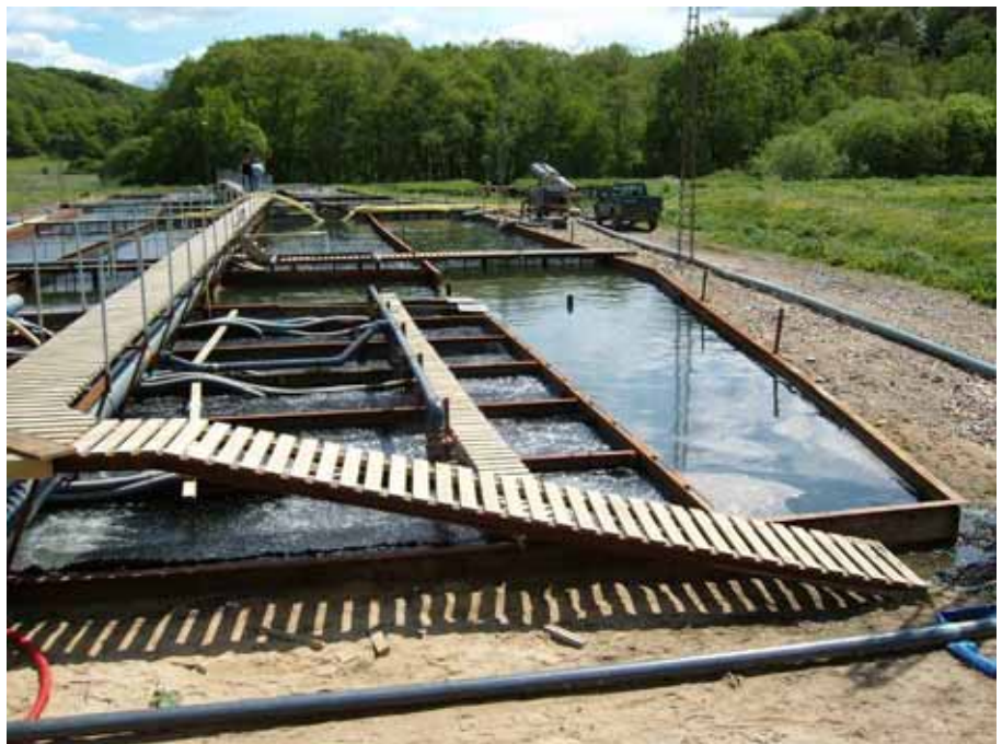
Foto 16.2.3.3 En del af produktionsanlægget på Tingkærvad Dambrug, forrest en del af biofiltrene.
