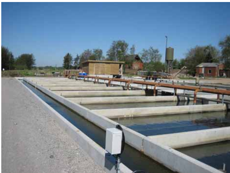
Foto 16.2.3.8 En del af produktionsanlægget på Nørå dambrug.
