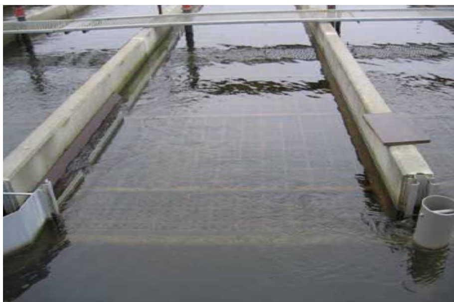
Figur 3.5 Eksempel på biofilter på et af de 8 modeldambrug.
