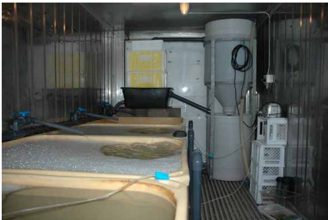
Fig. 3. Indretningen af container 1. Til venstre karrene. Nederst th. i baggrunden udløbskarret. Herfra pumpes vandet op gennem det dykkede biofilter i den koniske beholder, og løber tv. op i rislefilteret (gult). Fra opsamlingsstanken under rislefilteret løber vandet til karrene. Overskydende vand recirkuleres tilbage til udløbskarret (skråt rør midt i billedet).
