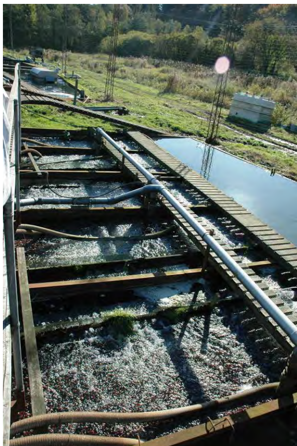
Figur 4.8. Biofiltersektioner fra model 3-dambrug, og nedenfor forsøgsopstilling med biofilterelementer udsat for forskellig behandling. I hvert delforsøg med samme mængde biofilter-elementer tilsættes en kendt mængde \text{NH}_4\text{Cl} eller \text{NaNO}_2 og der udtages vandprøver over tid til senere analyser. [Foto: LFP]
