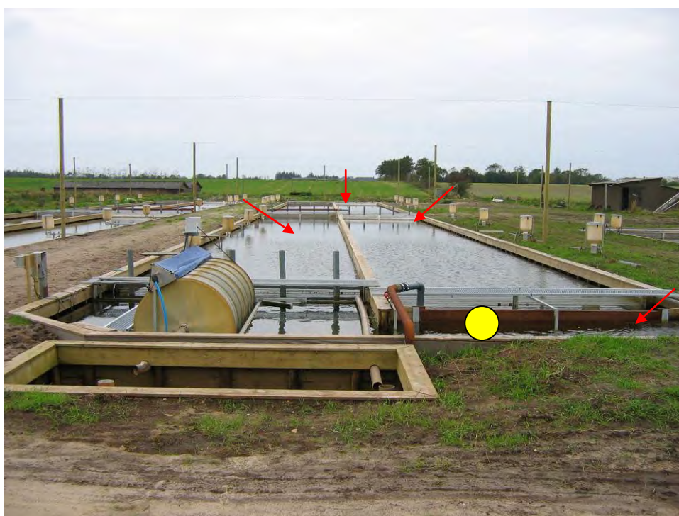
Figur 4.1. Billede af model 1-anlæg med en af de 800 m 3 store opdrætsenhed med mikrosigte t.v. og en af fire beluftningsbrønde forrest t.h. Dosering i belufterbrønde er angivet med røde pile; gul cirkel indikerer position for vandprøvetagning. [Foto:LFP]
