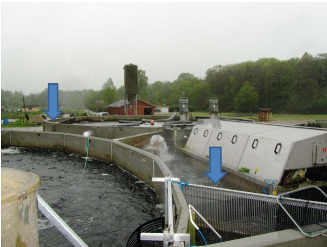
Figur 1.4.1 Produktionsenhed på Dambrug L. Vandprøver og målinger blev udtaget ved indløb til og udløb fra biofiltret.
