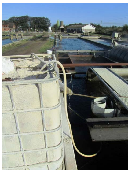
Foto 1.3. Kalkdosering til biofilter
