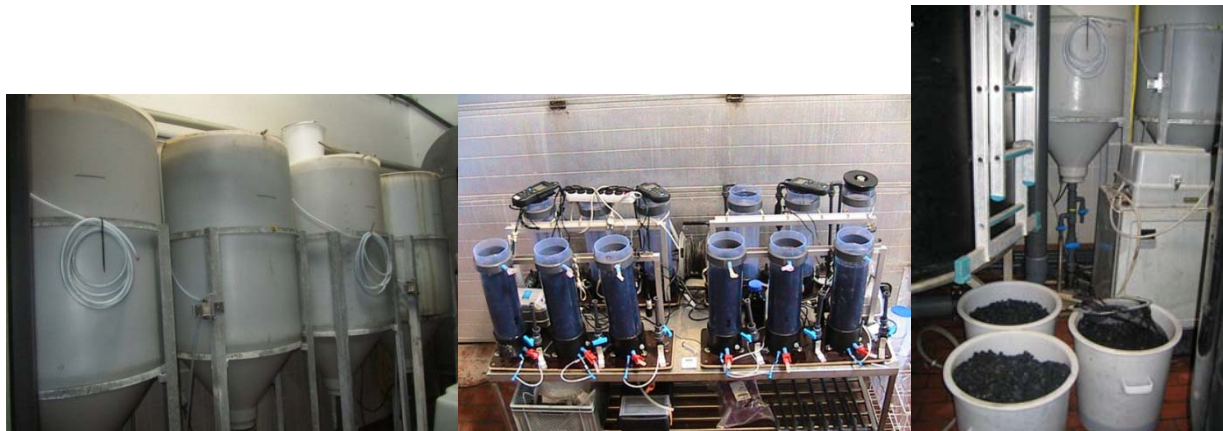
Figur 1.8.1. T.v. foto af forsøgsanlæg med 4 biofiltre (2 fixed bed og to moving bed). I midten ses bench scale-opstilling, hvori koloniserede biofilterelementer er overført, og t.h. ses biofilter elementer fra det dykkede biofilter udtaget fra hhv. top, midt og bund.
