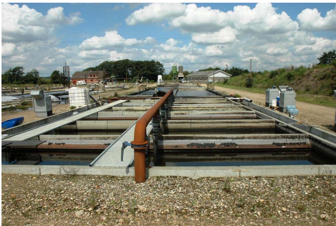
Figur 1.3.1. Anlæg 1 på Dambrug N. Prøvetagere opstillet ved indløb til biofiltre og ved udløb fra to af anlæggets 6 biofiltersektioner.
