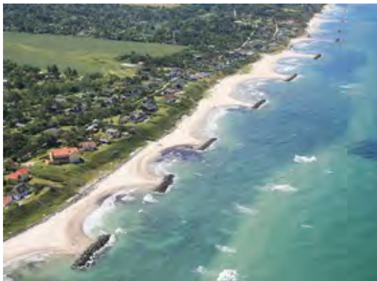
Foto 4. Bølgebrydere i form af store sten langs den nordsjællandske kyst (Kilde: http://kysterne.kyst.dk/hvad-er-boelgebrydere.html ).
