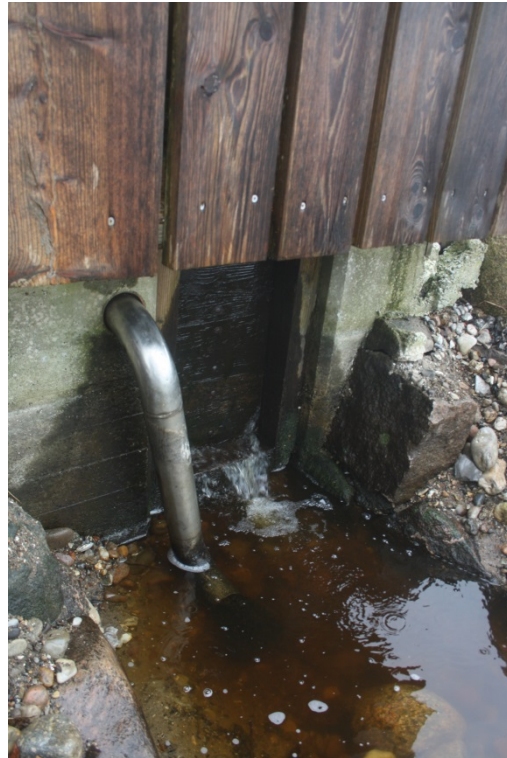
Figur 11. Nedstrøms ser ålefælden således ud. Selve Hellebækken er spærret af et stigebor. Metalrøret som ses på billedet, indeholder en kammat, som de juvenile ål kan kravle op igennem, og derved havner de inde i ålefælden.
