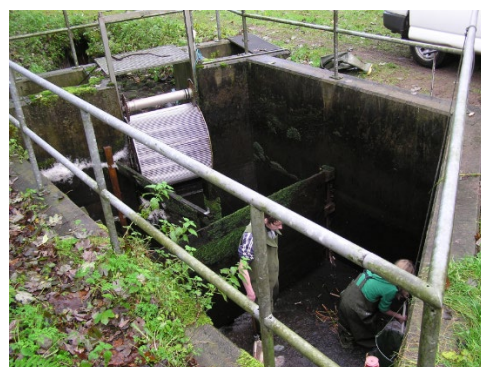
Figur 3. I venstre side ses principskitse af indløbskanal og omløb ved Vestbirk Vandkraftværk (ikke målfast). I højre side ses et fotografi af fiskefælden med tromlefilter placeret der hvor vandet løber ud af fælden.
